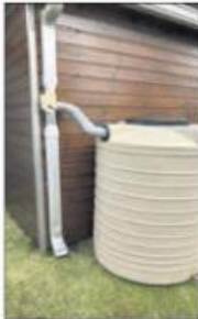
Le collecteur de gouttière anti-moustique que Verléo a mis au point pour récupérer l'eau de pluie et l'envoyer vers le réservoir.
