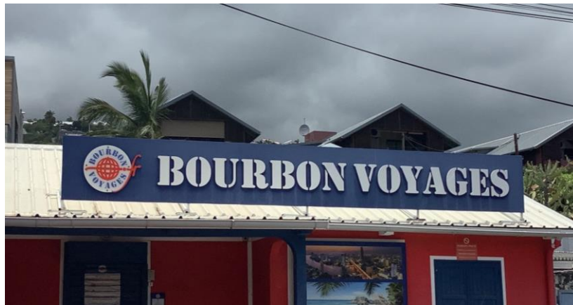
Enseigne sur toiture avec un panneau plein (illégal)
